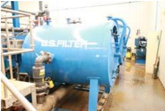
Préfiltre (membranes de 5 microns). Récupération de particules en suspension (sable, limon, petits poissons, particules en suspension)
